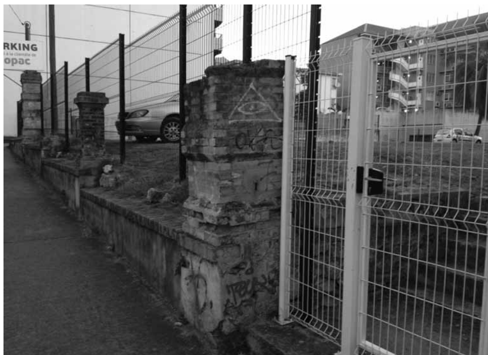
Figure 5 Piliers en briques qui matérialisent l'emplacement de la maison Nielly. On remarque à droite le départ d'un escalier, servitude demandée par Auguste Pelletier au moment de la cession de ce lot à ses petits-enfants.
